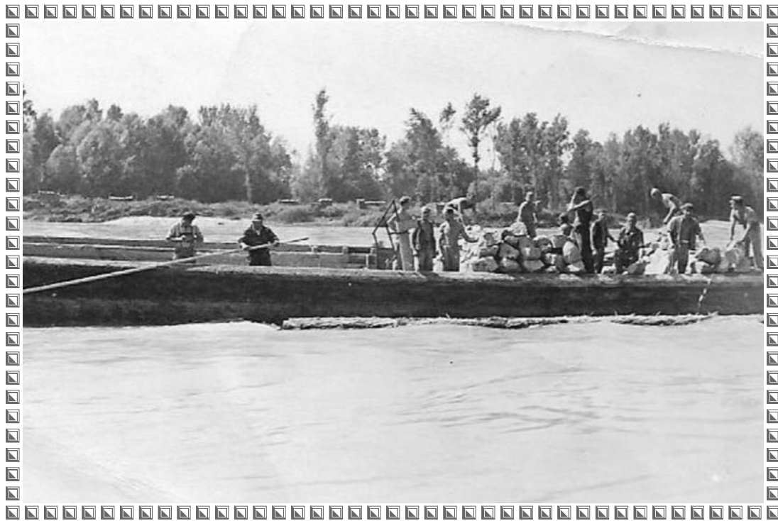
Arbeiten zur Uferbefestigung an der Donau
