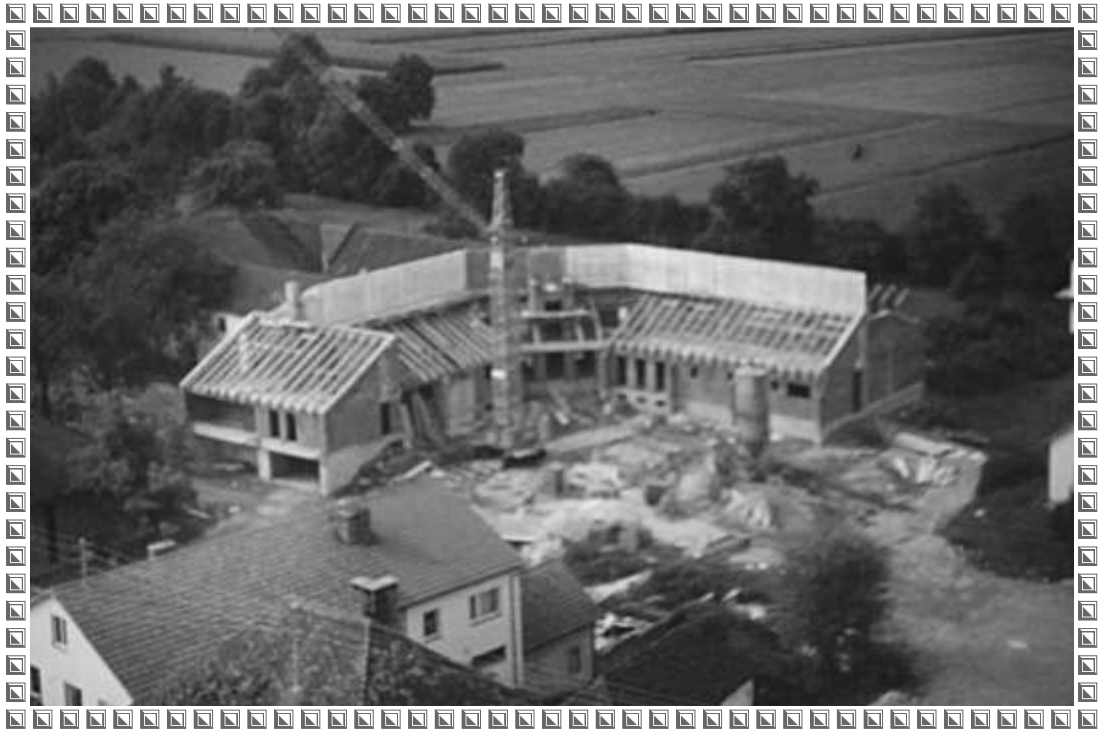
Der Pfarrhofbau ist in vollem Gange
